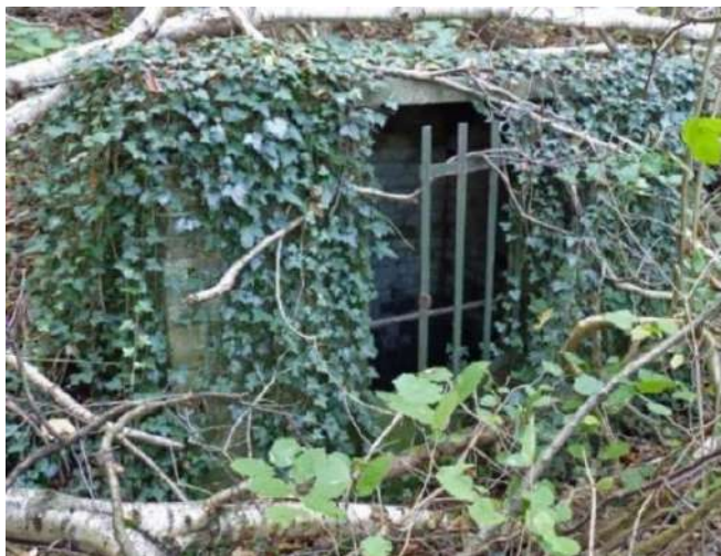
La ruine du puits situé dans la petite vallée descendant des Communes vers la rue des Bouvreuils
