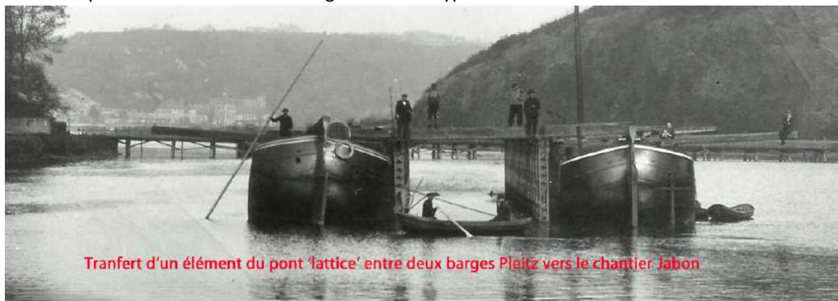
Déchargement d'un tronçon 'lattice' au chantier Jabon
