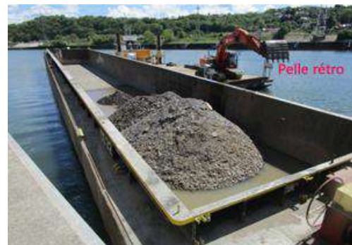
Pelle-rétro sur un ponton approfondissant la Meuse en aval de L'approfondissement
