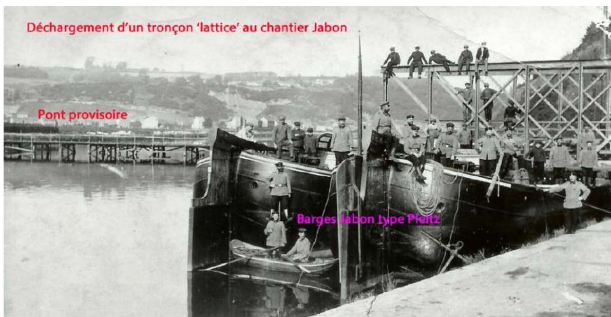
Tranfert d'un élément du pont 'lattice' entre deux barges Pleitz vers le chantier Jabon
