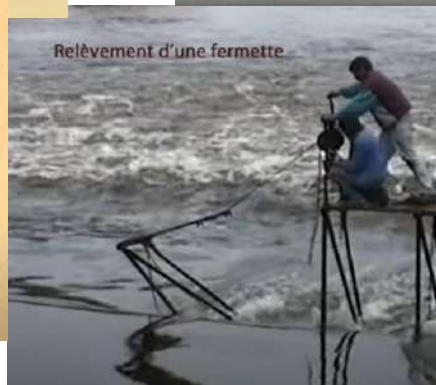
Relèvement d'une fermette dont la chaîne est cassée
