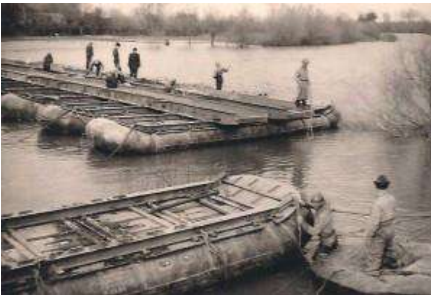
Détail d'un pont Treadway
